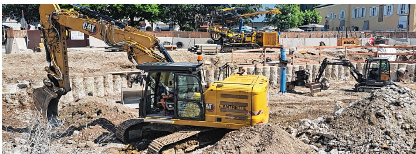
Seit einigen Tagen kann auf beiden Baustellen in der Stadtmittte wieder parallel gearbeitet werden. FOTO HADERSBECK
